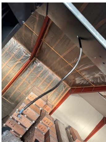
Fig. 18 – Montering af Bomsensor og beslag
