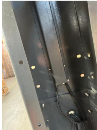
Fig. 20 – Montering af afdækning indvendigt i søjler
